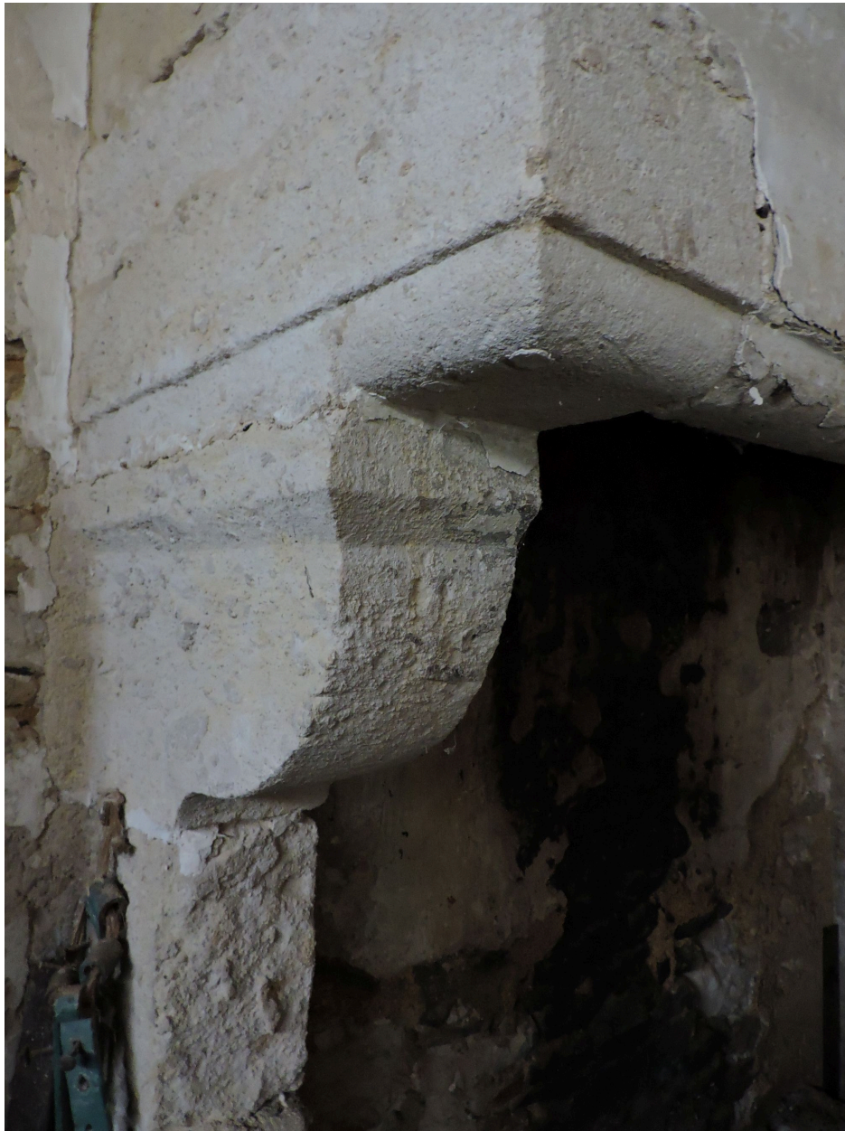
Un des corbeaux soutenant la hotte de la cheminée.
