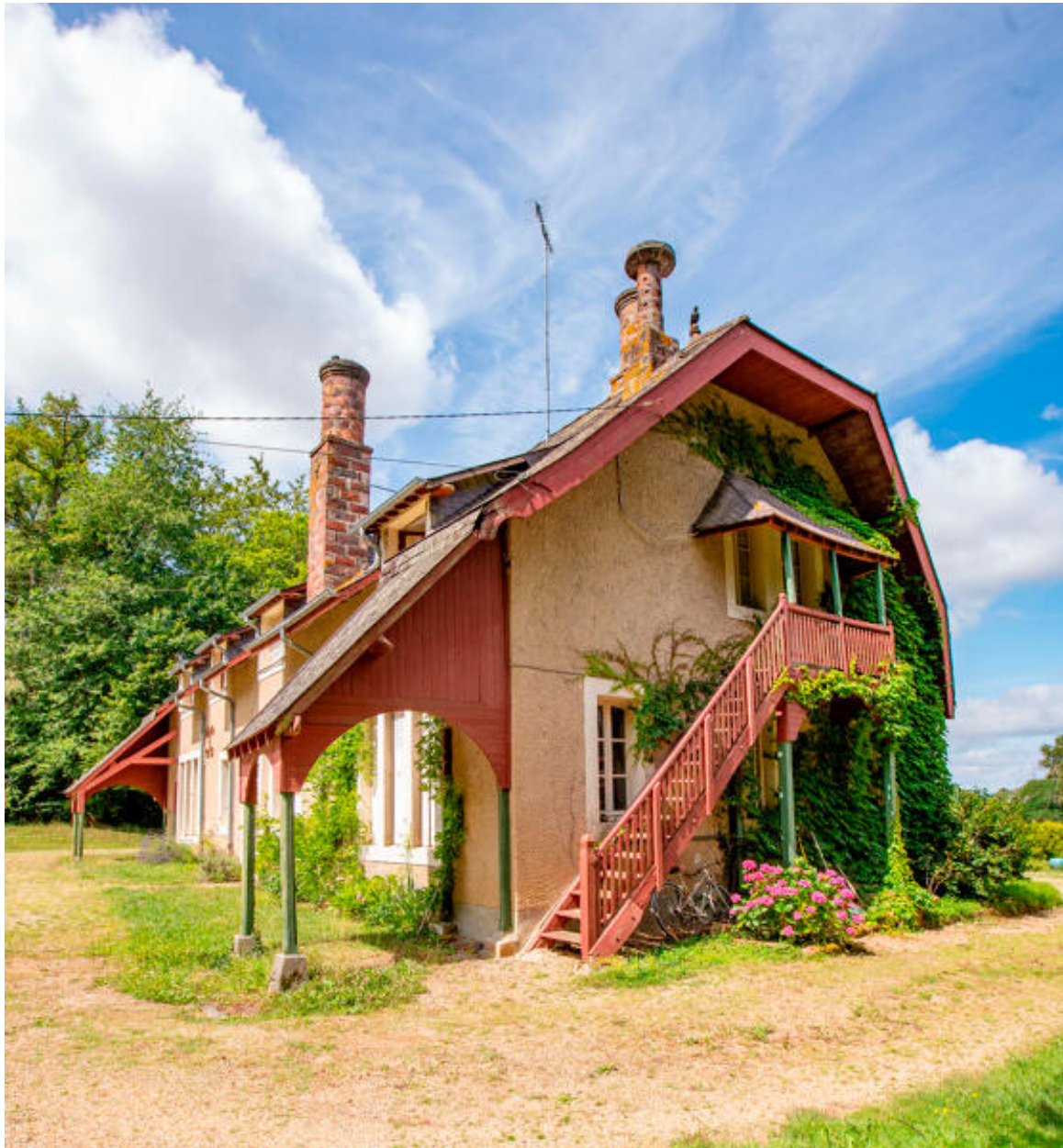
L'escalier du mur-pignon.
