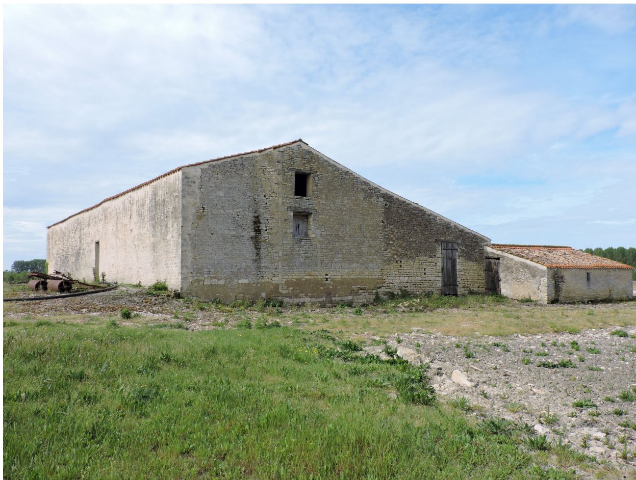
Les dépendances vues depuis le nord-est.
