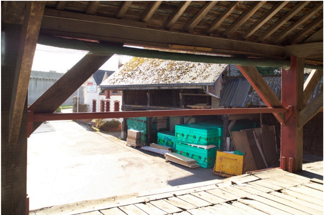
Cour d'entrée, vue des hangars.
