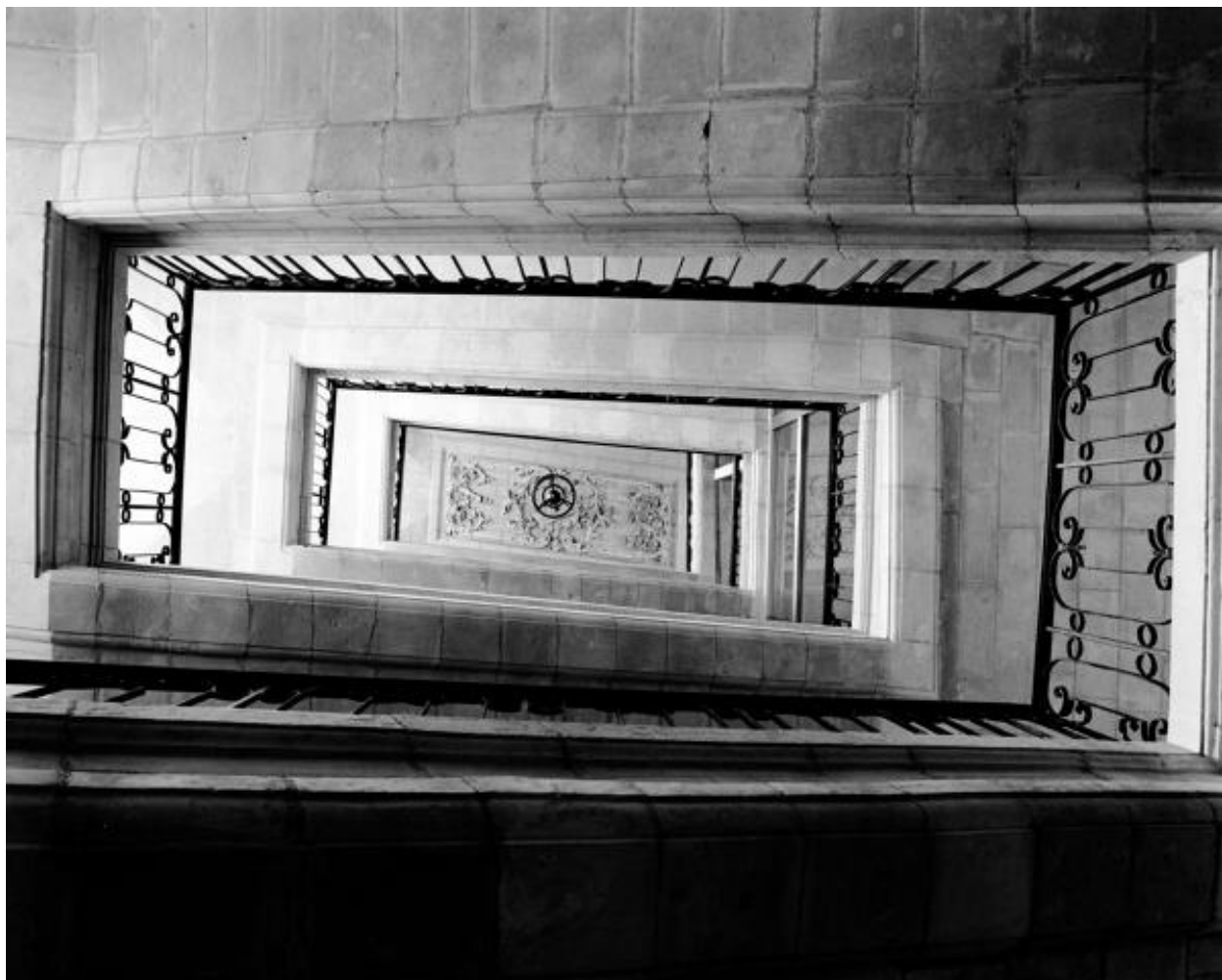
Aile sud de l'abbaye, escalier d'honneur : vue en contre-plongée.
