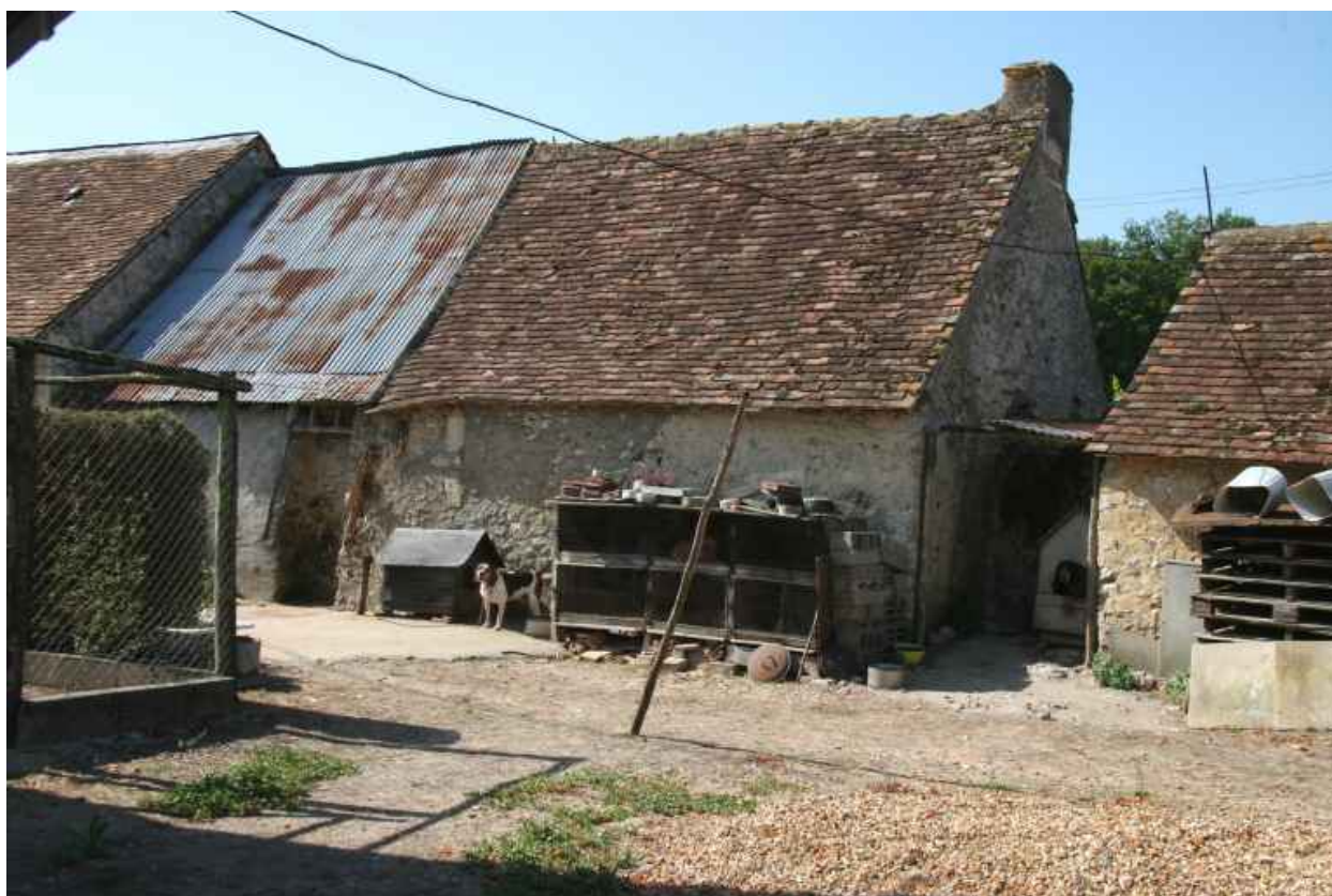
Maison n° 3 : façade postérieure.
