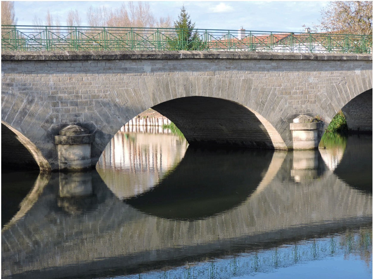
Le grand pont vu côté amont, depuis le sud : détail, arche centrale.
