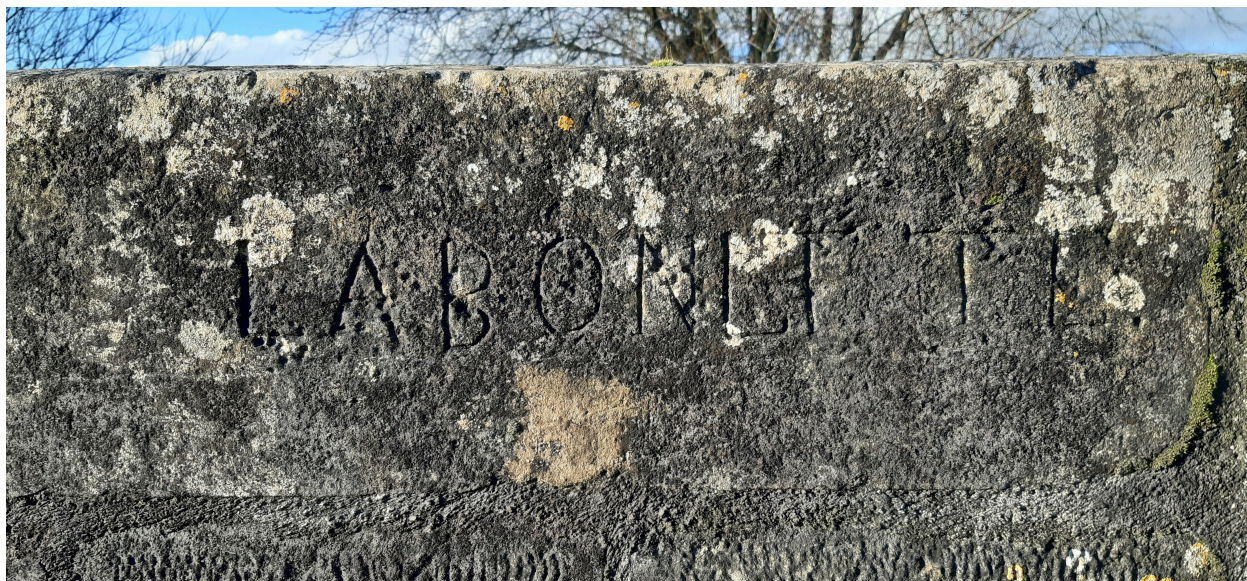
Graffiti sur le parapet nord du pont : surnom Labonette.
