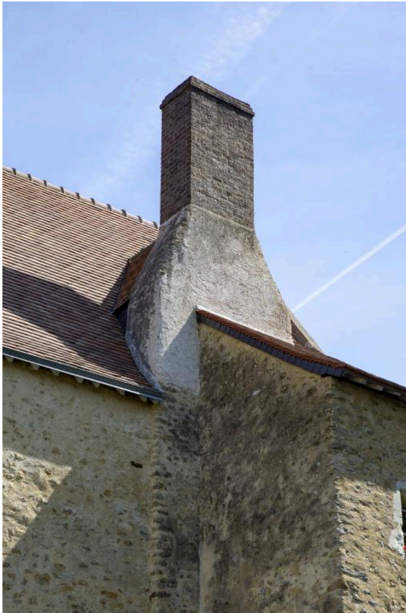
La souche de la cheminée principale.
