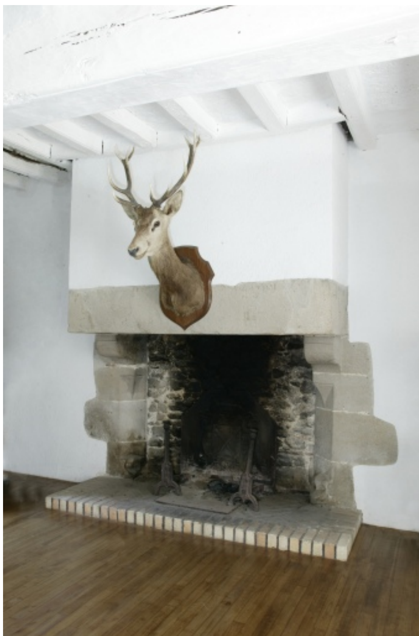
Cheminée nord au rez-de-chaussée.
