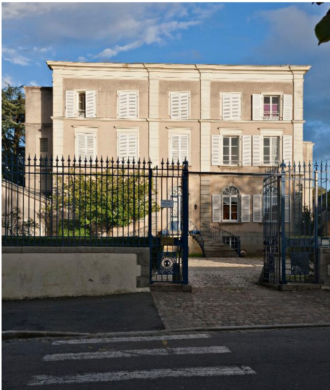
Elévation antérieure : vue d'ensemble depuis la rue.
