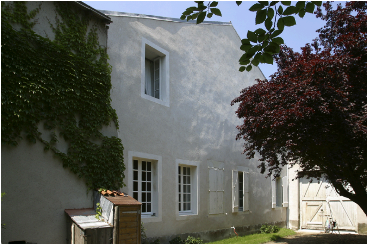
Le pignon de la partie adressée n° 50 quai Chassagne vu depuis le jardin.
