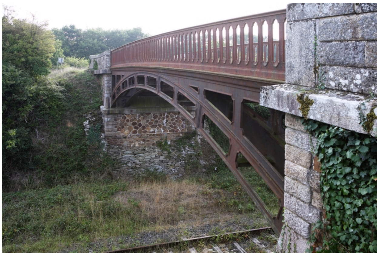
Pont-route en fonte.
