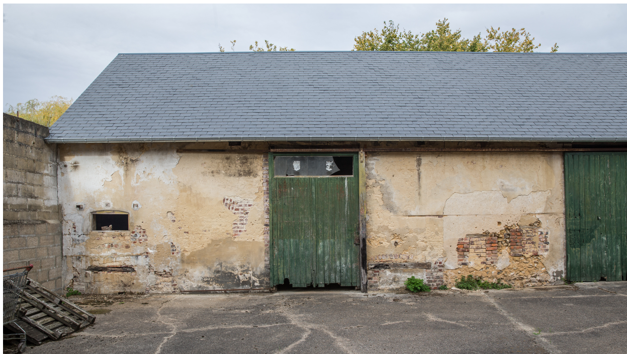
Le bâtiment de dépendance.
