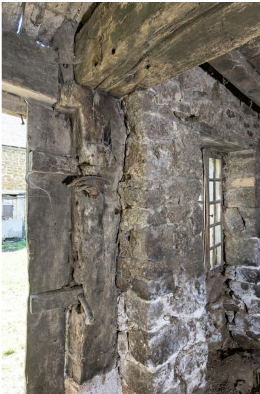
Logis sud, montant de la porte.
