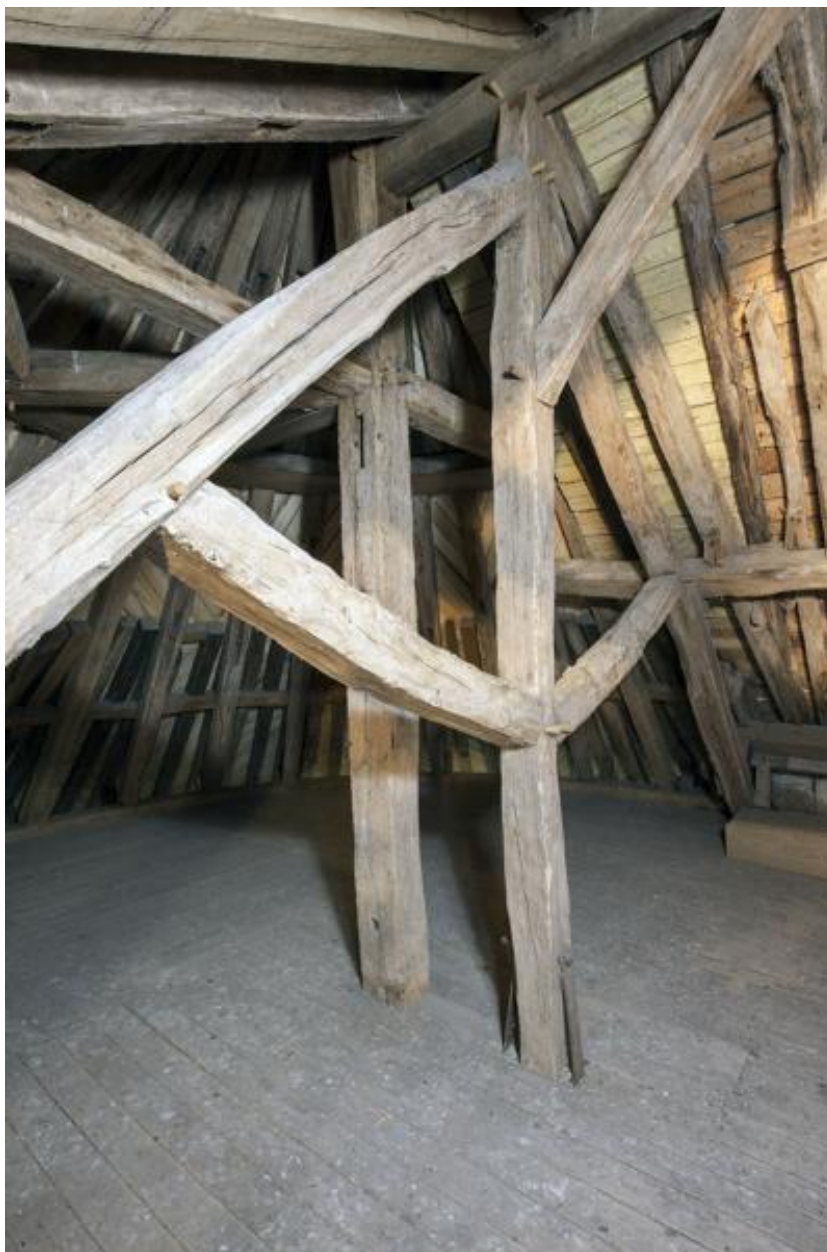
Charpente de la tour orientale du châtelet.
