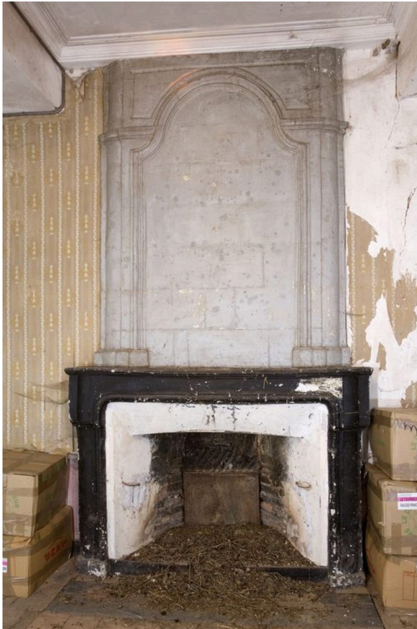
Intérieur du pavillon, premier étage : la cheminée, sur le mur nord.
