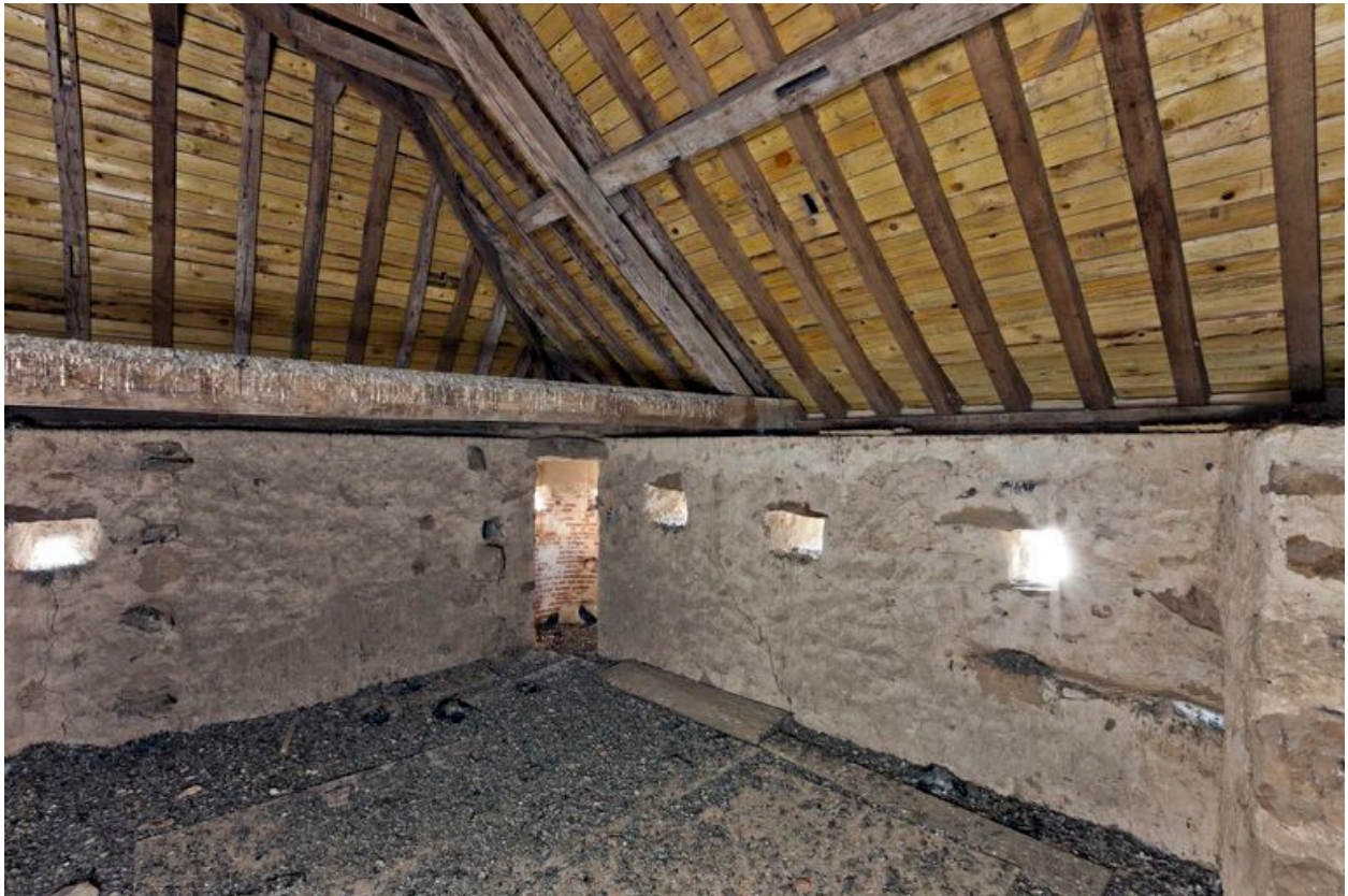
Partie droite du comble de l'avant-corps et accès à la tourelle.
