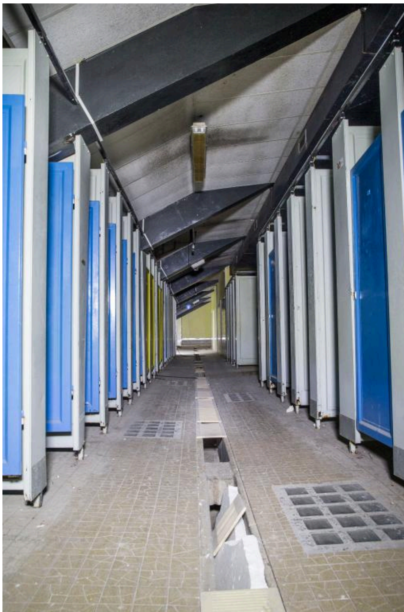
Vue des vestiaires de l'étage de la piscine.
