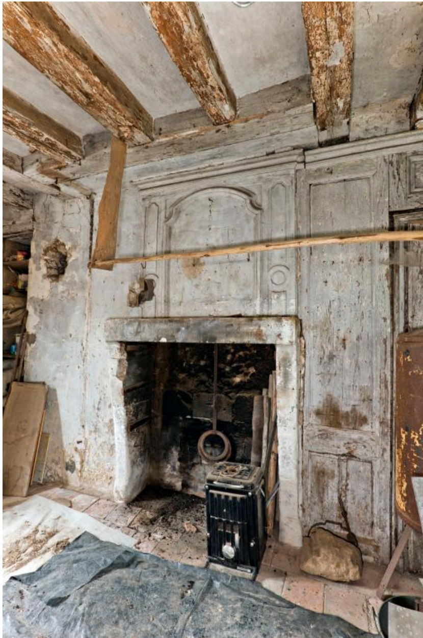
Maison, pièce à feu ouest : cheminée.
