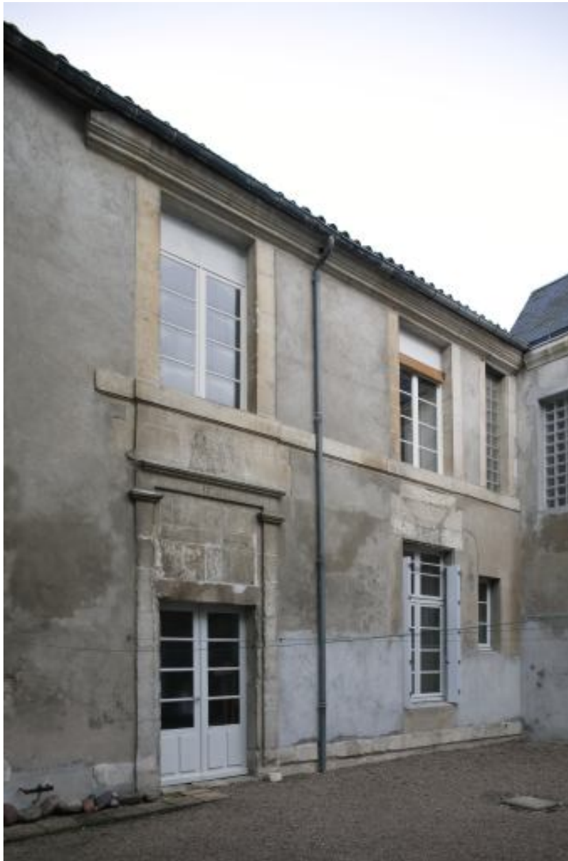
Eléments de l'ancien couvent de l'Union chrétienne, réutilisés par les carmélites : façade sur cour intérieure du bâtiment rue du Grand-Carmel, portant la date 1730.
