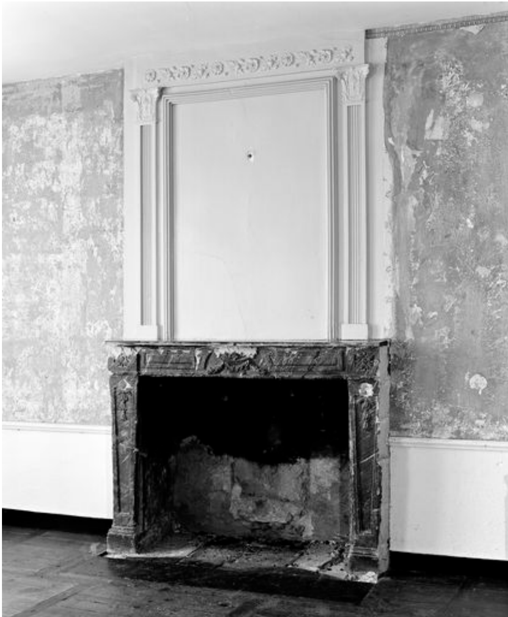
L'étage : la cheminée de la pièce située à l'angle nord-est (1998).
