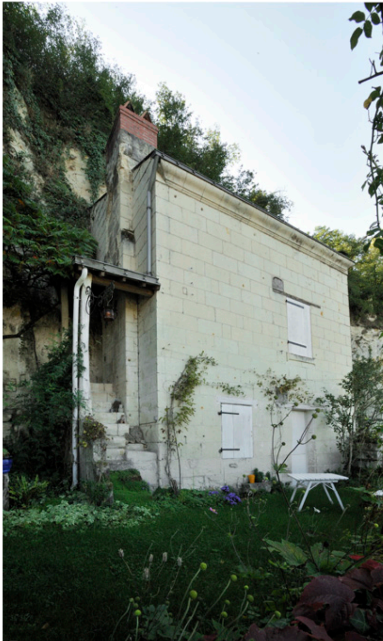
Maison en appentis, accolée au coteau.
