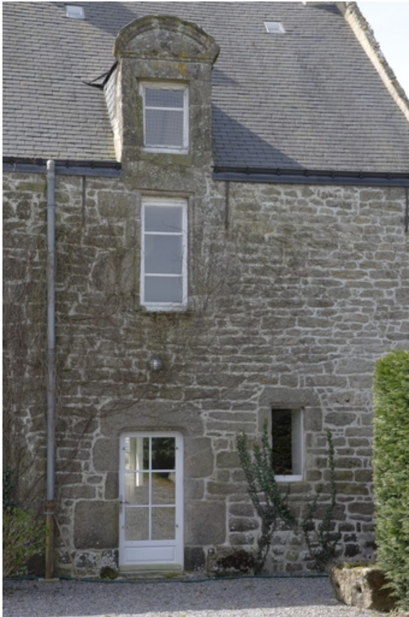
Façade nord. Vue de l'extension.
