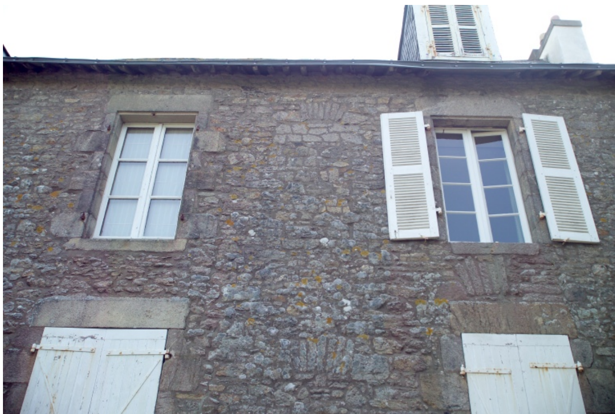
Détail des arc de décharges sur la façade postérieure.
