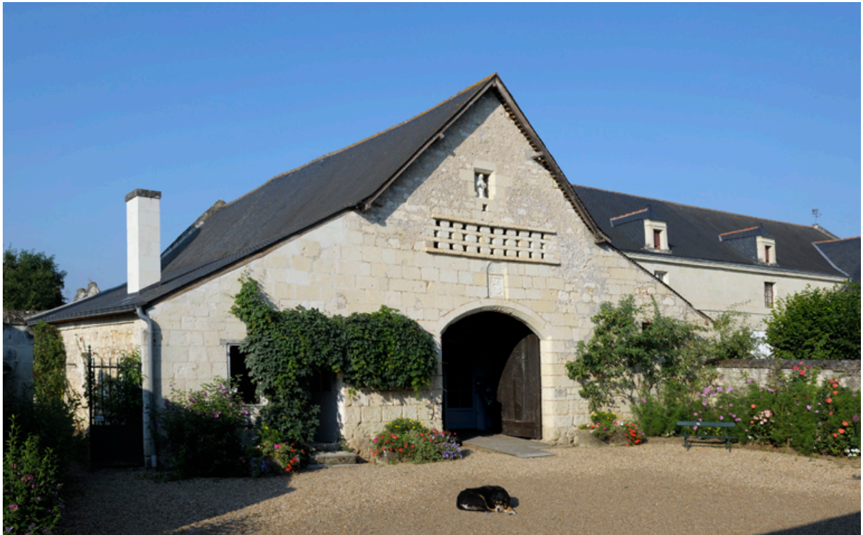
Grange, construite à la fin XVe siècle ou au début du XVIe siècle.
