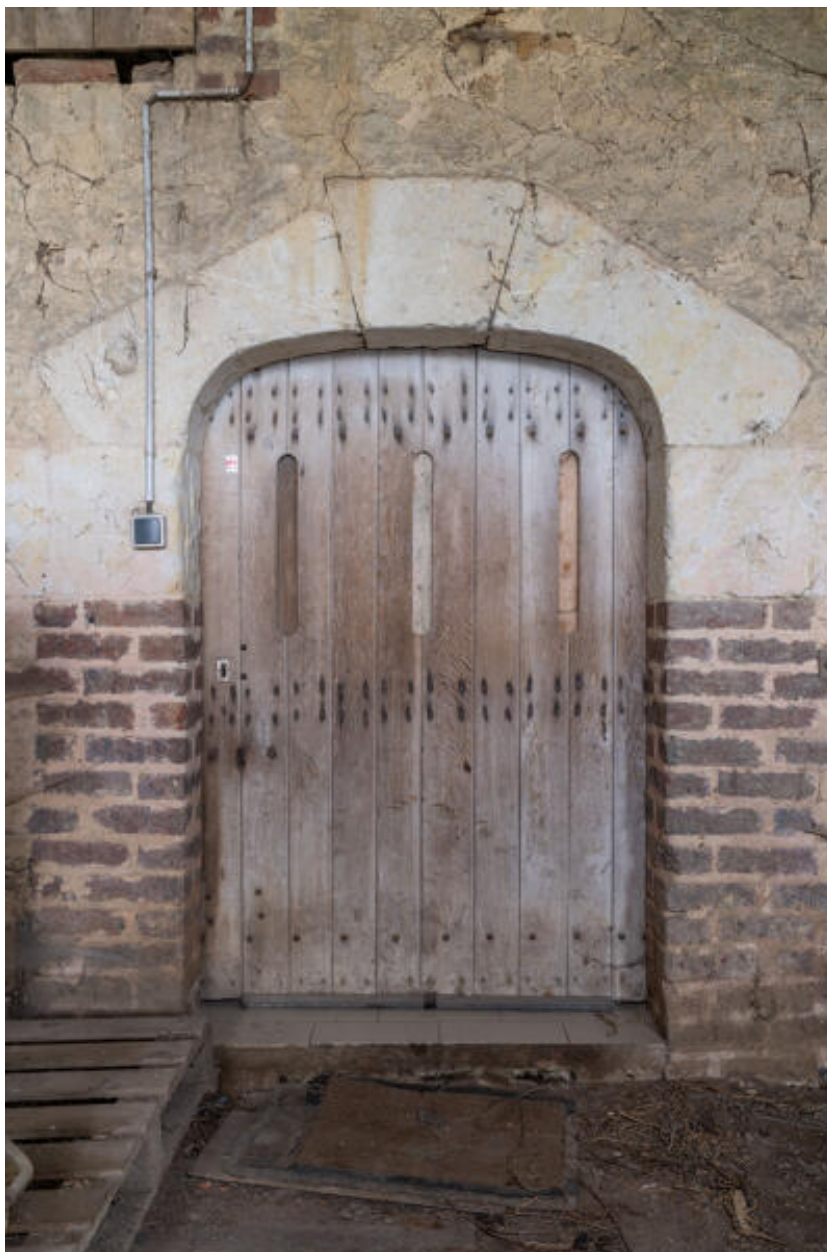
Cellier à l'arrière du logis : porte.
