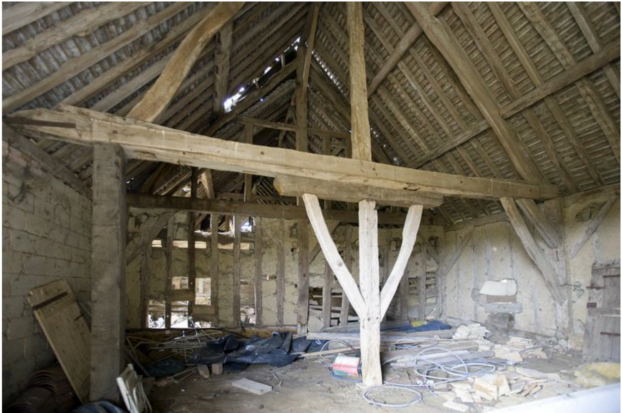
Grange-étable, vue intérieure.
