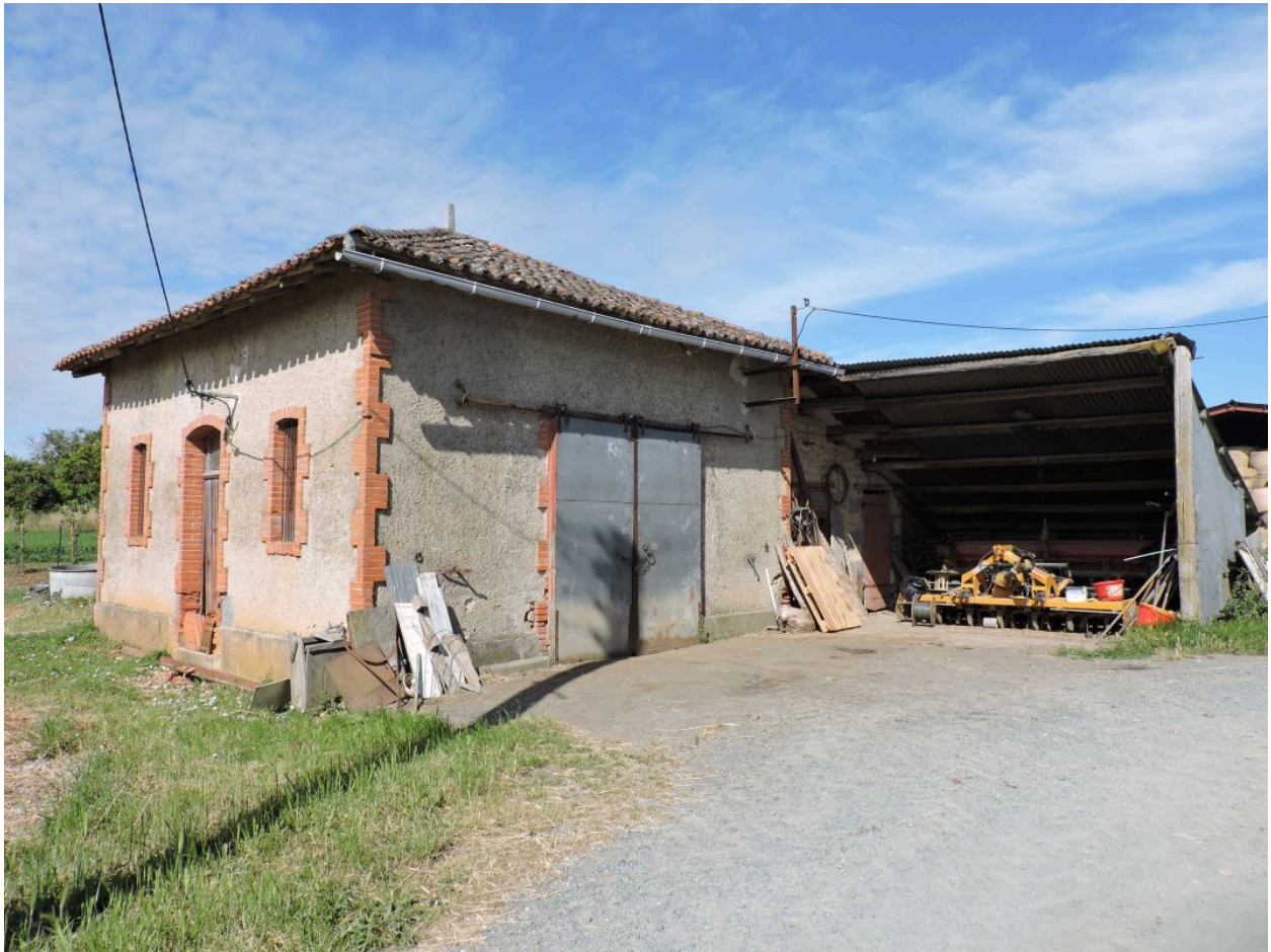
L'ancien abattoir vue depuis le nord-est.
