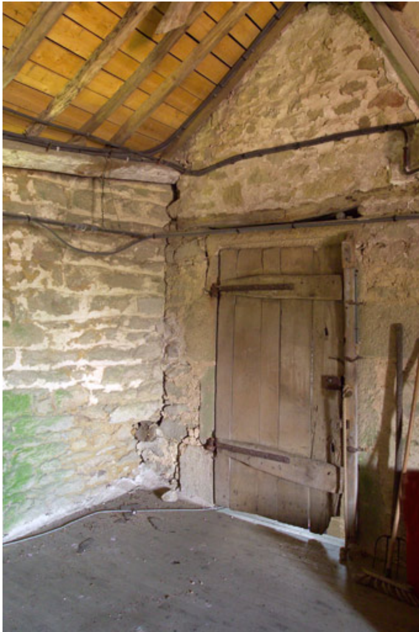
Mur derrière la tour dans le comble des anciennes écuries.
