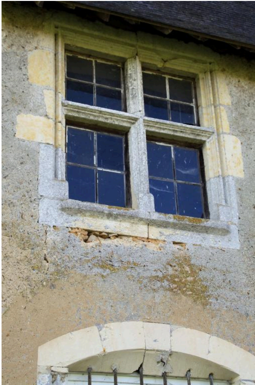
Logis, façade est, 1er étage, baie travée droite.
