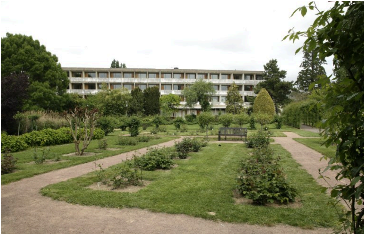
Vue prise du sud.
