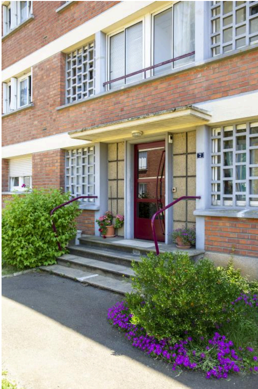
Vue de l'entrée du bâtiment D3 depuis les espaces verts.
