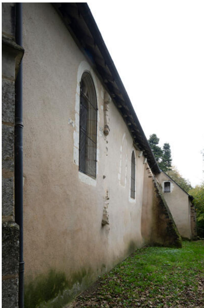
Mur extérieur de la nef côté sud.
