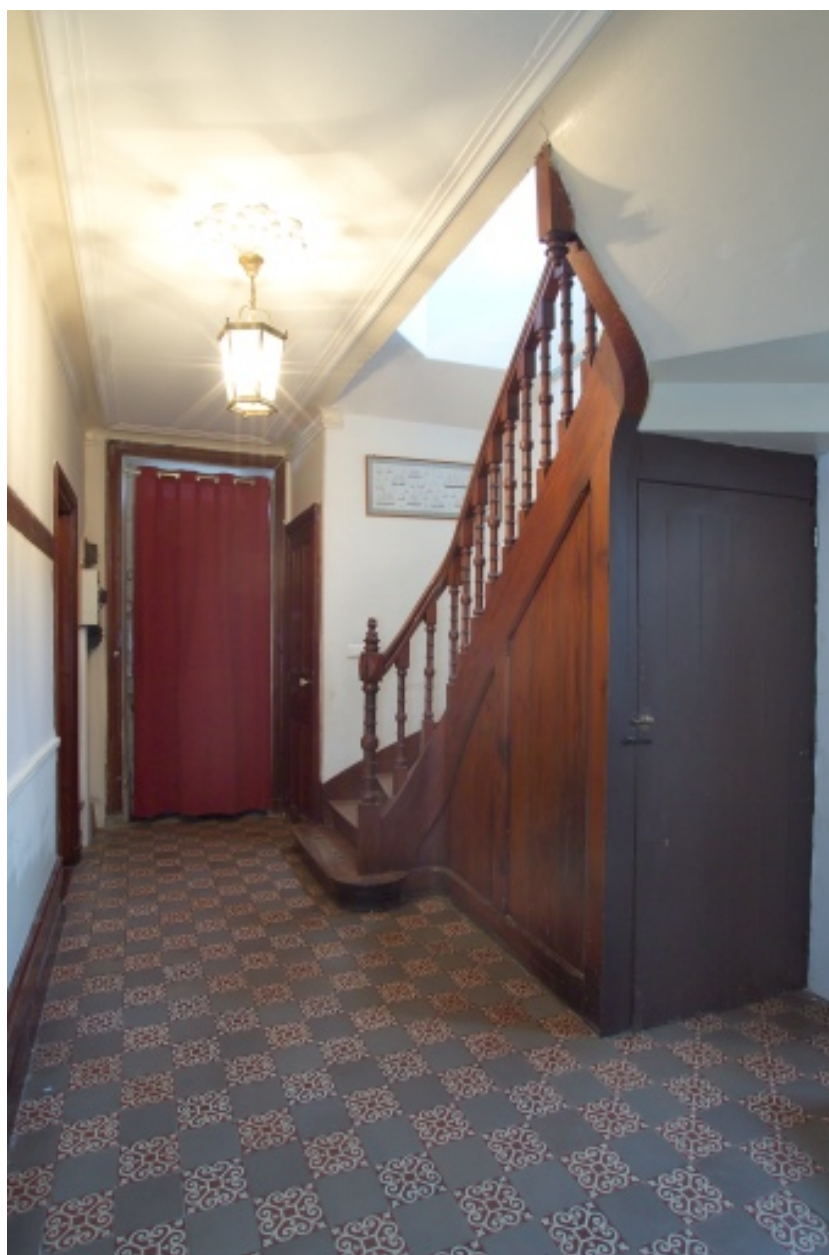
Hall du rez-de-chaussée de la maison.
