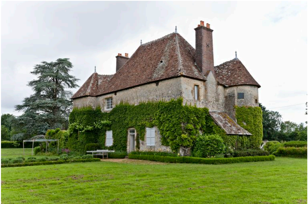
Vue générale depuis le sud.
