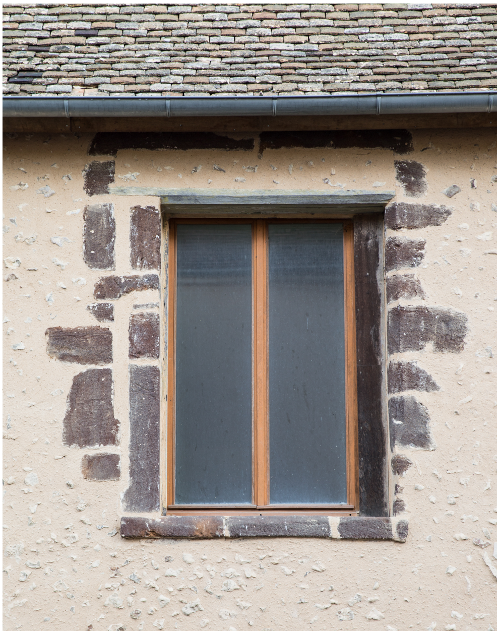
Le détail d'une croisée remaniée.
