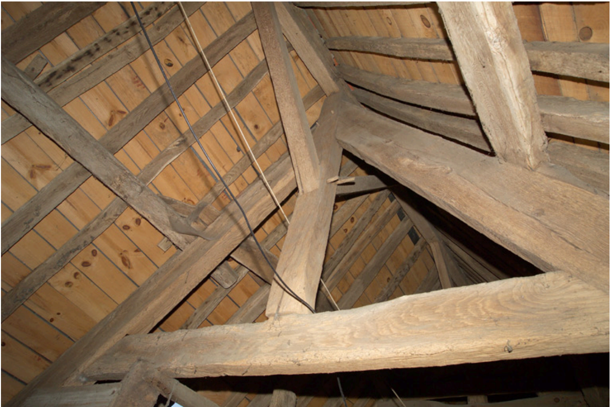
Corps principal, combles, détail de la charpente.
