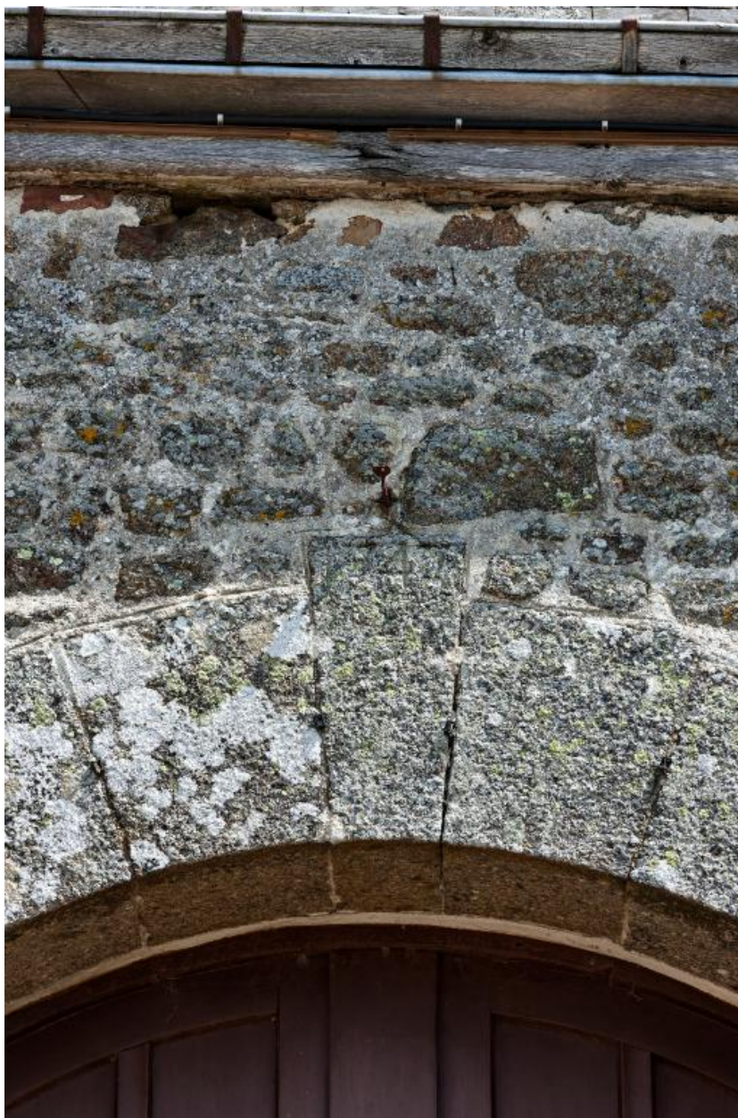
Facade occidentale : détail de l'arc de la porte, de la corniche et de la gouttière.
