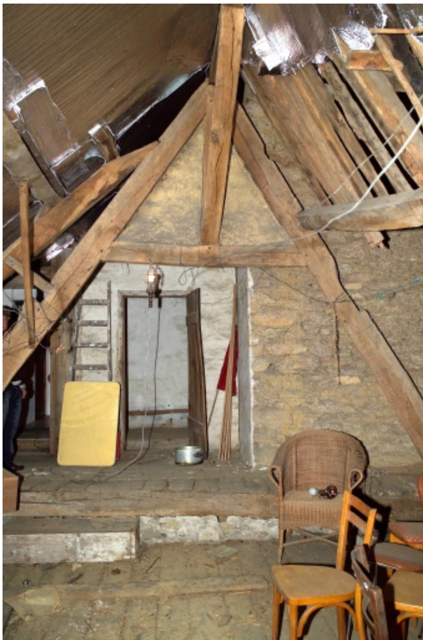
Charpente de la partie arrière, vue vers le Nord.
