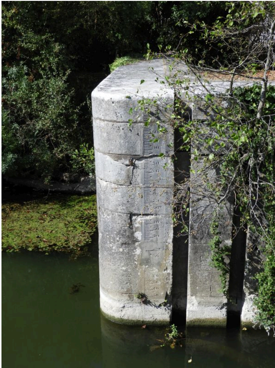
Echelle graduée pour mesurer le niveau d'eau, à la tête aval de l'écluse, rive droite.
