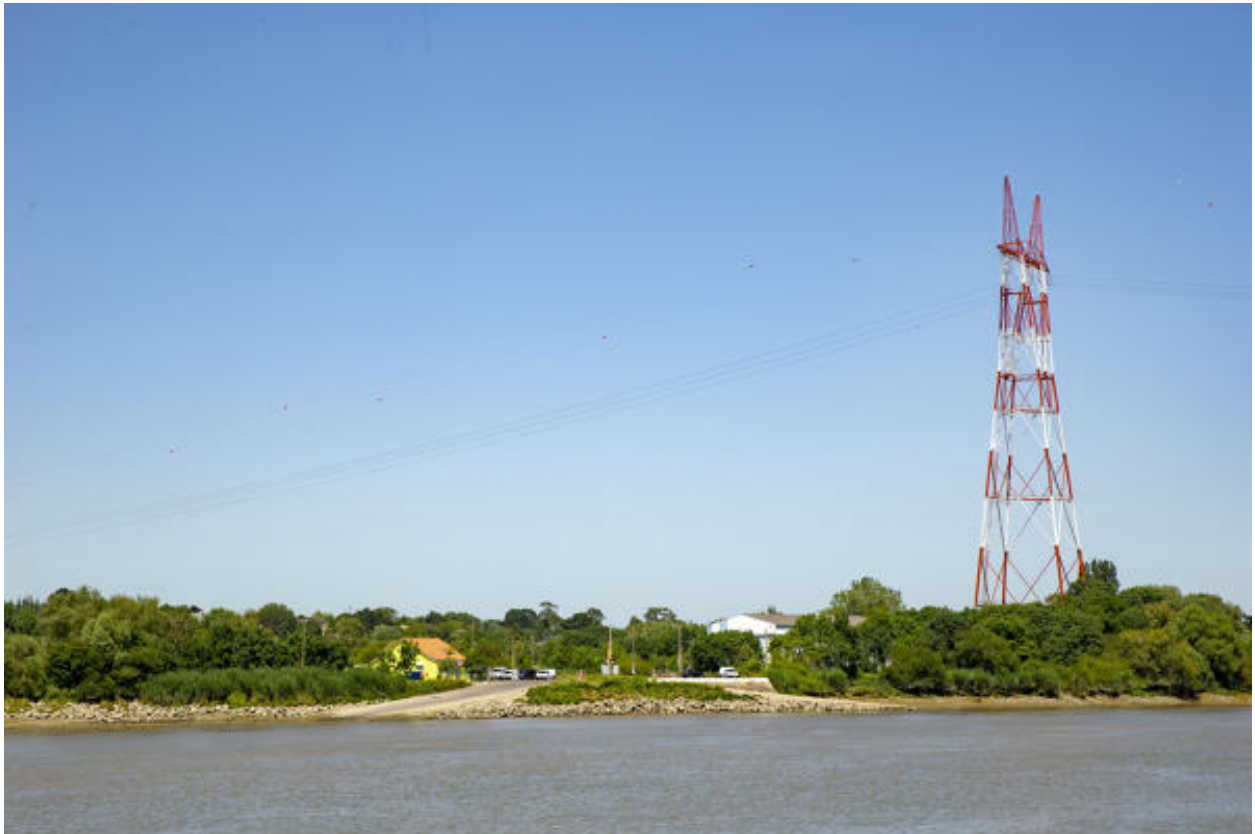
Vue d'ensemble du l'embarcadère de bac depuis la rive gauche.
