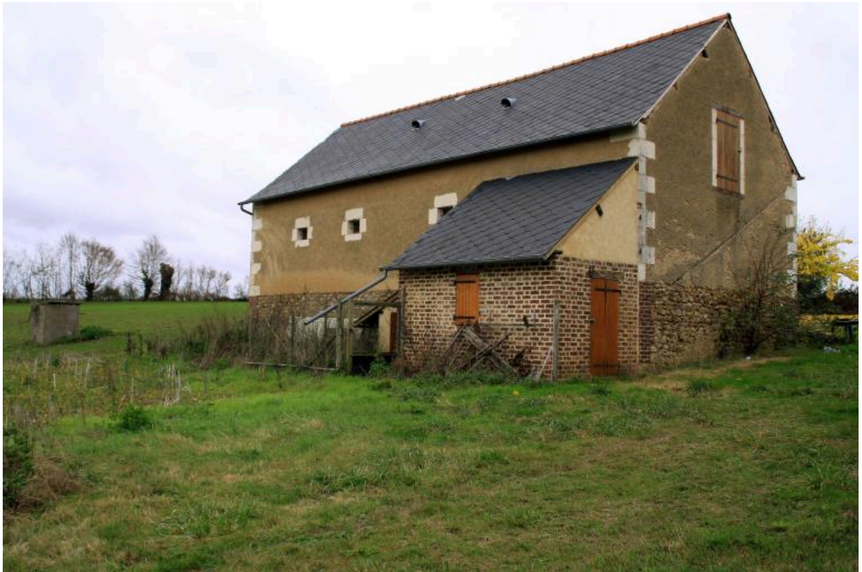
Vue de volume de la grange-étable.
