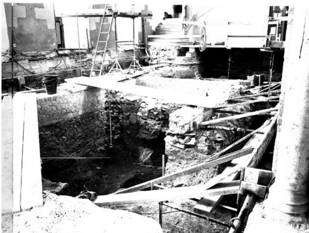
Abbaye, la salle du chapitre durant les fouilles de 1986-1987 : détail sur les strates de maçonneries antérieures au XIIe siècle.
