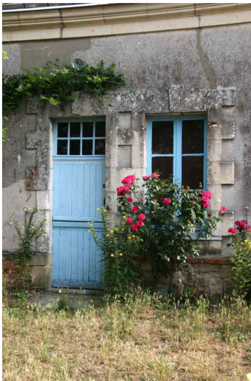
Porte et fenêtre de la partie habitée.
