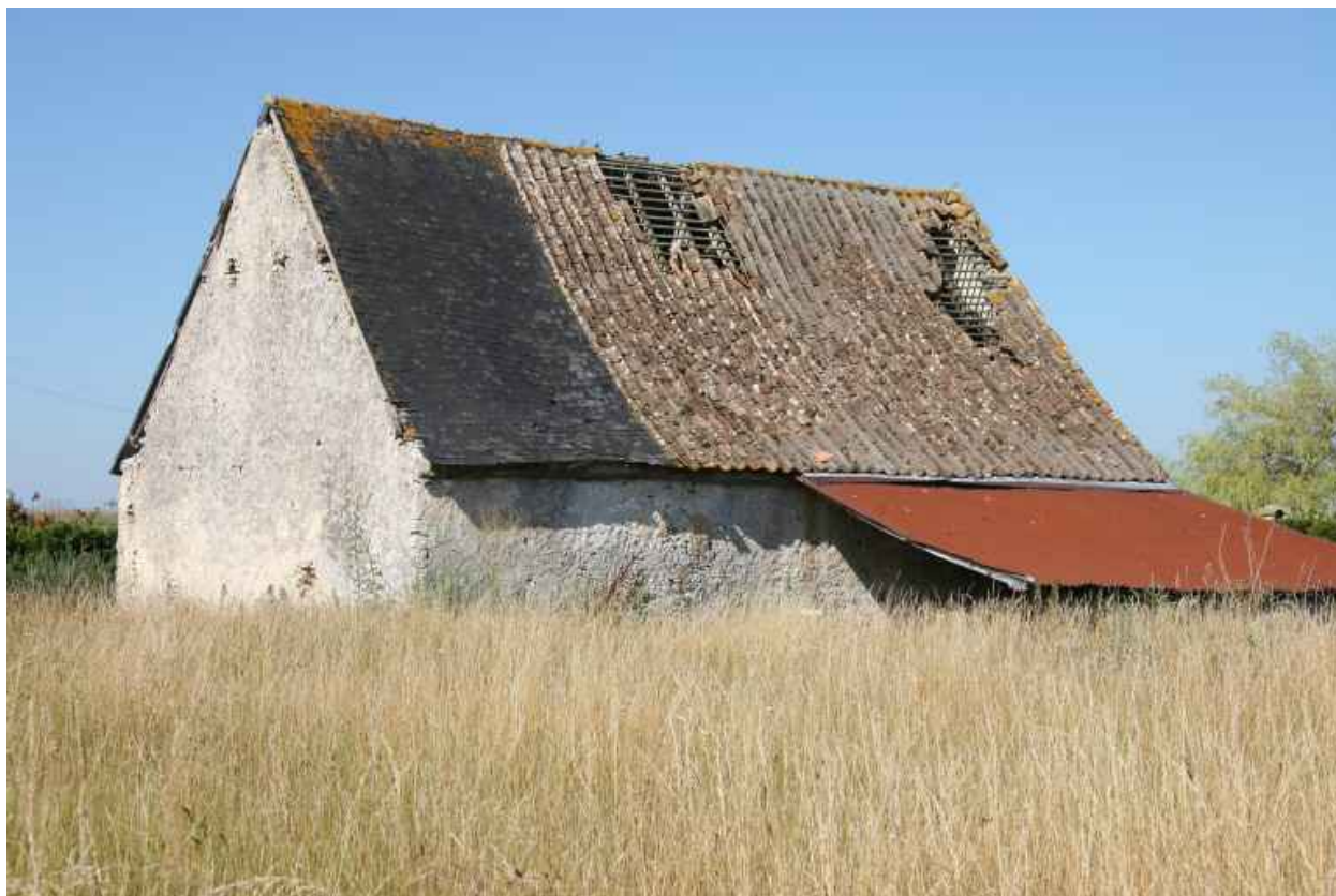
La grange : couverture de tuiles courbes.
