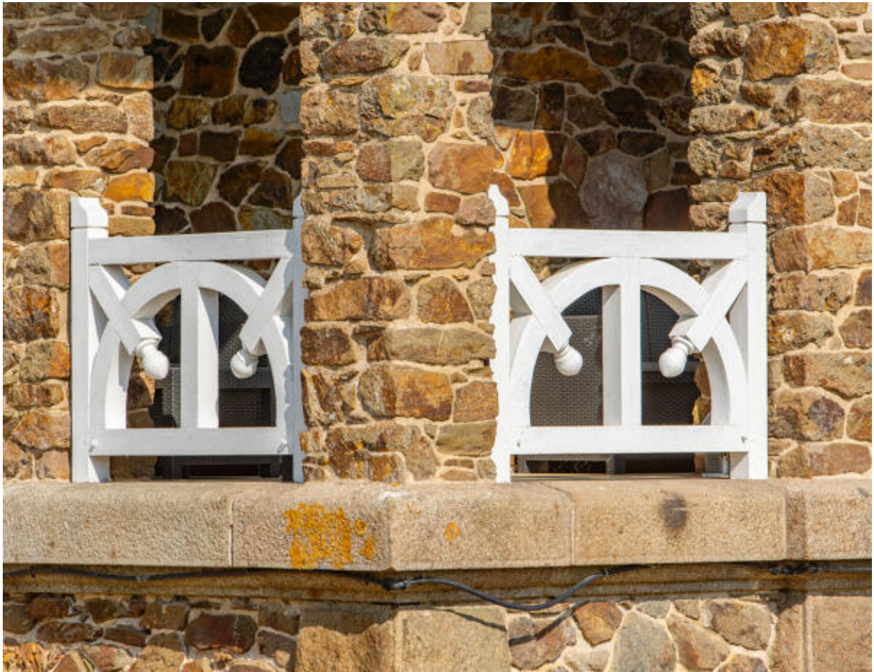
Le garde-corps de la terrasse.
