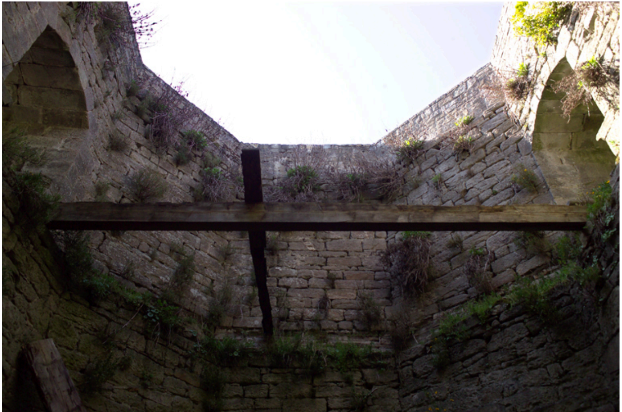
Parement interne du mur ouest, premier étage.
