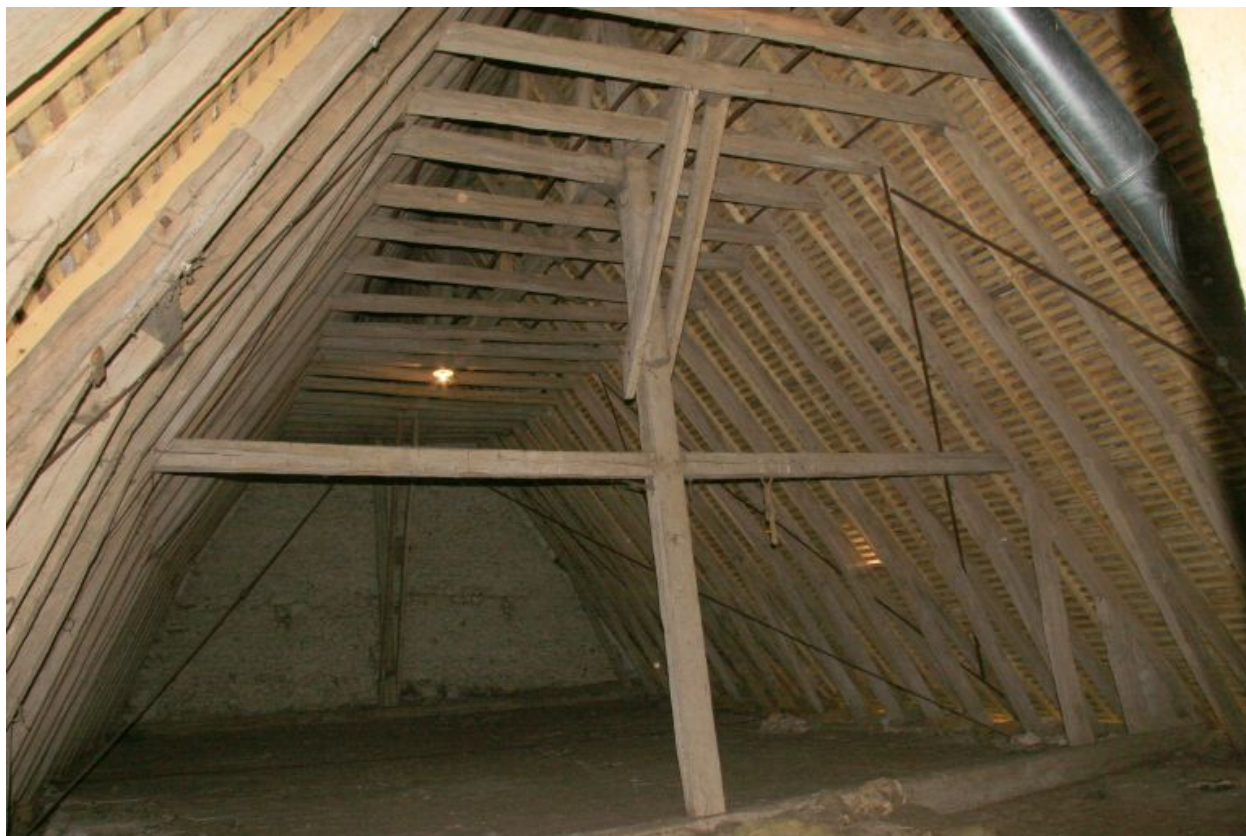
Bâtiment des greniers : comble.
