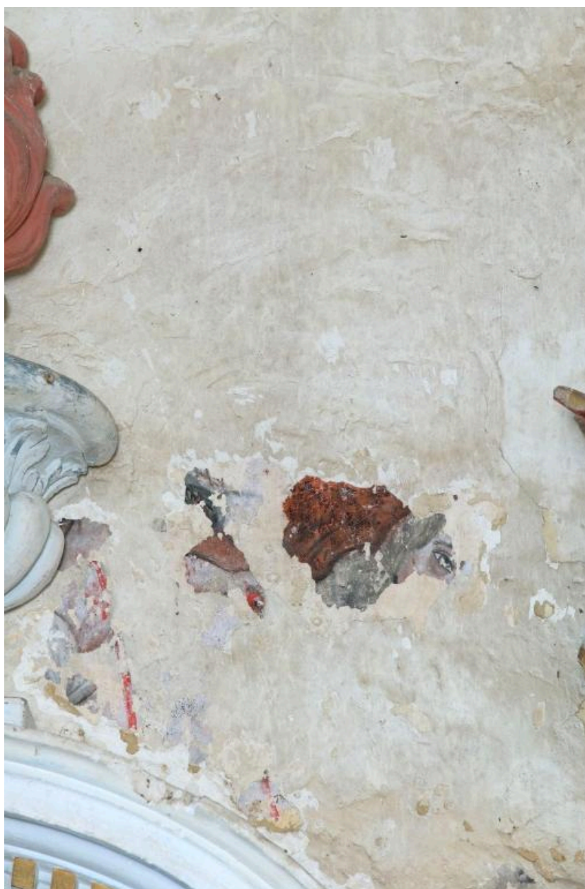
Chœur, mur oriental, côté sud, partie supérieure : détail d'un visage.
